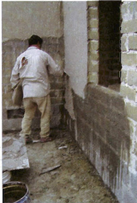
Foto 57. Lechareada de cemento previa al revoque
