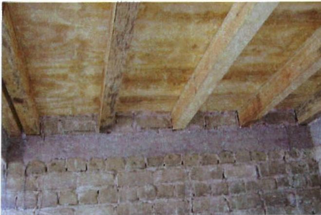
Foto 37. Vista inferior de losa de entresuelo
