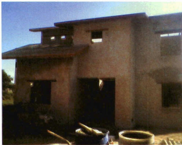
Foto 49. Aspecto de losa de azotea
