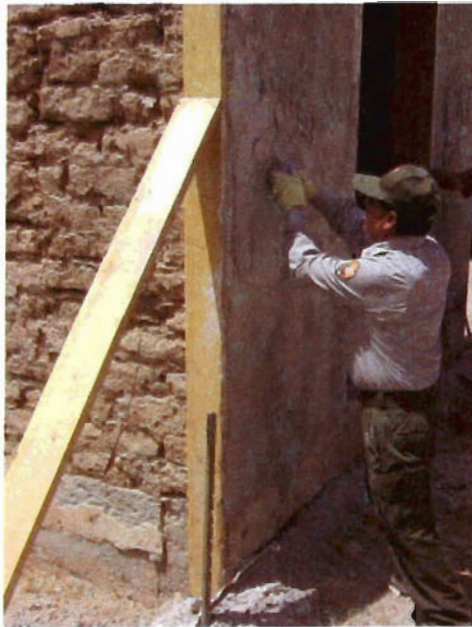
Figura 8. Aplicación de recubrimientos de cal
