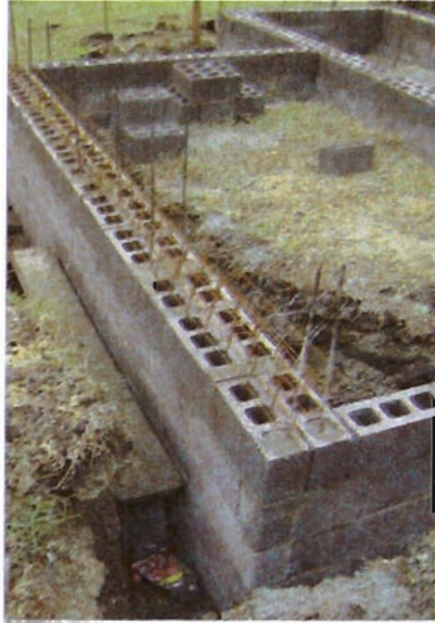
Foto 10. Cadenas de cimentación e impermeabilización del rodapié
