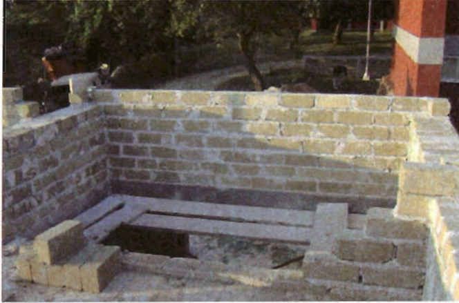
Foto 40. Desplante de muros planta alta recámara poniente
