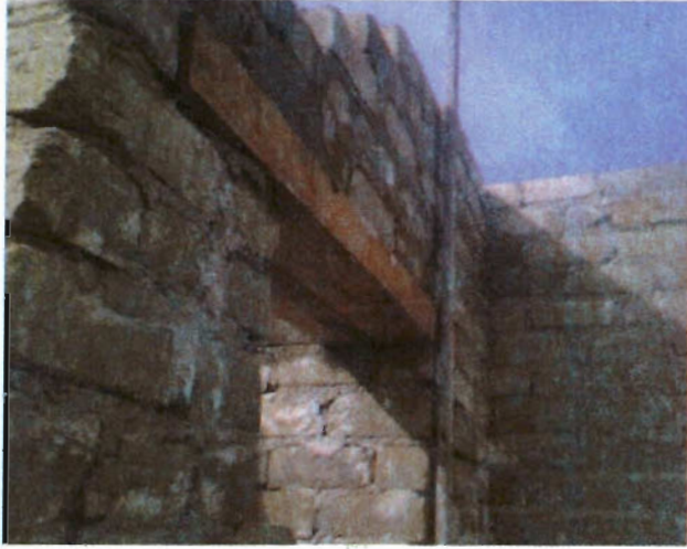
Foto 24. Detalle de dintel
