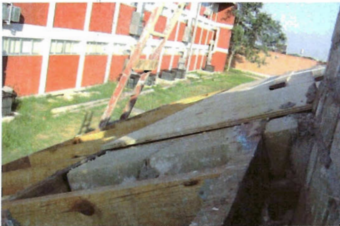
Foto 56. Detalle de ensamble de vigas de losa de azotea
