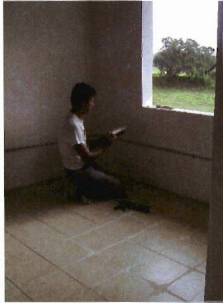
Foto 63. Proceso de colocación de piso cerámico sobre losa en entrepiso
