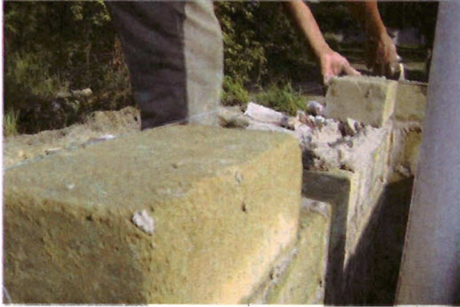
Foto 18. Detalle de aunedmiento de las hiladas de BTC
