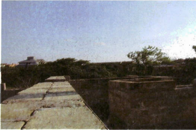
Foto 20. Muros dobles de BTC
