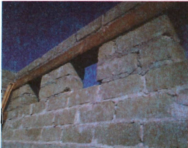
Foto 25. Detalle de dintel en ventilas de la planta alta
