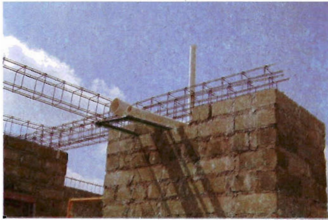
Foto 27. Cimbrado de cadenas de cerramiento en el cuarto de baterías
