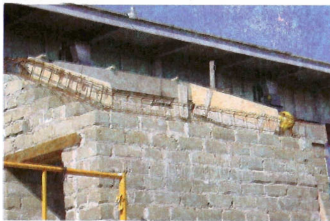
Foto 27. Cimbrado de cadenas de cerramiento en el cuarto de baterías
