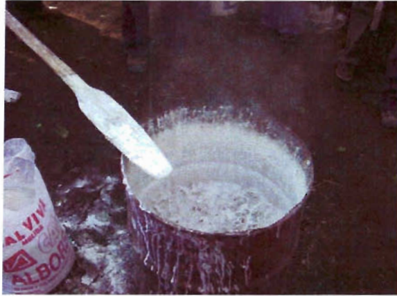
Figura 6. Reacción durante el apagado de la cal
