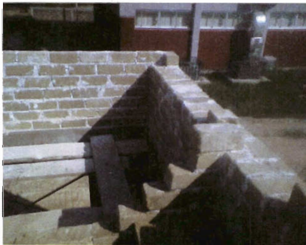
Foto 43. Detalle de muros planta alta
