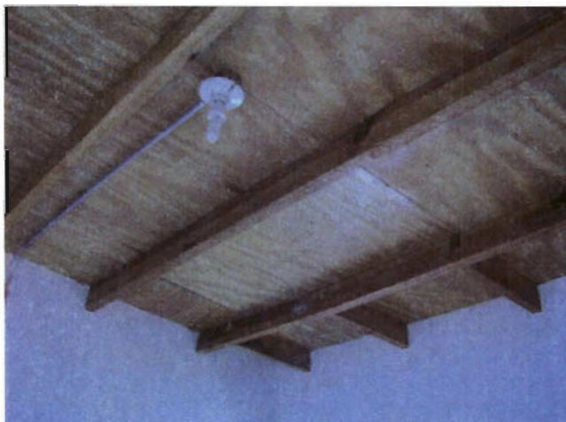
Foto 66. Instalación eléctrica en losa de azotea
