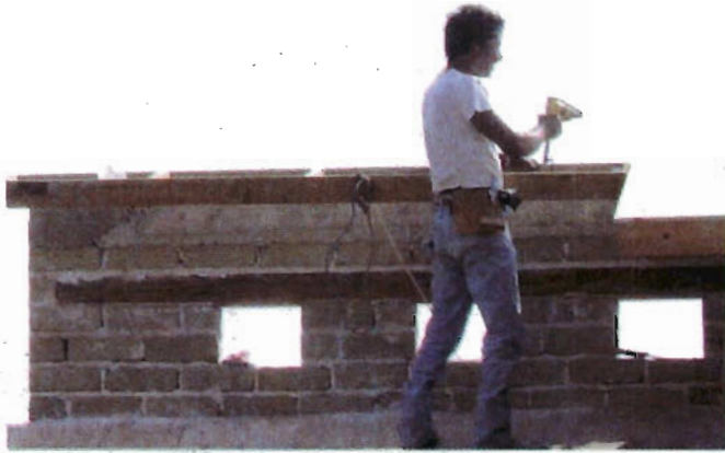
Foto 54. Proceso constructivo de losa de azotea
