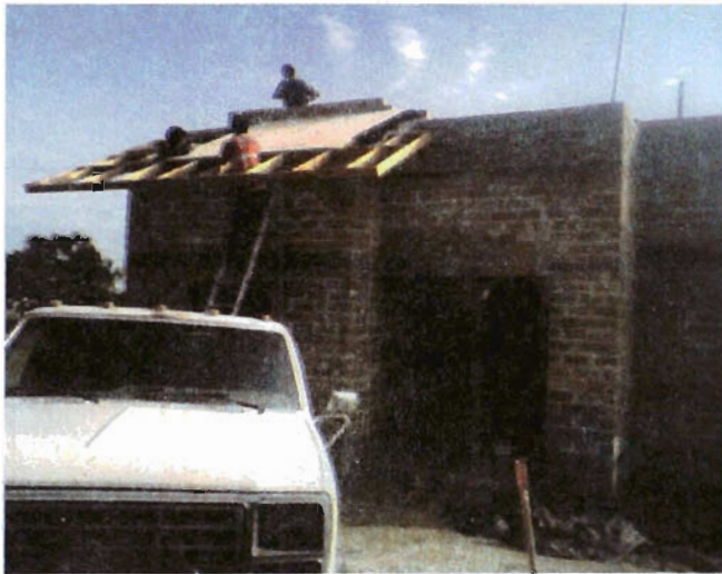
Foto 48. Detalle de losa en azotea de sala
