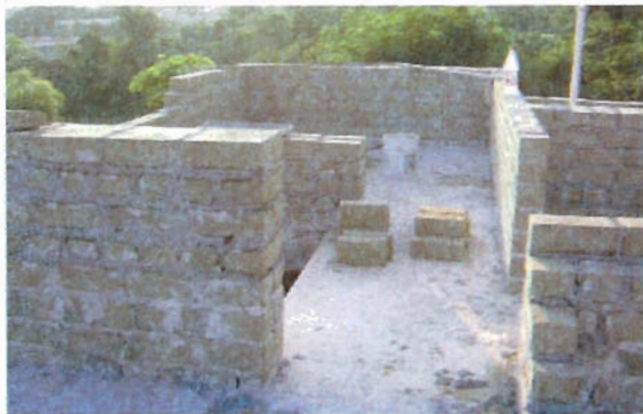
Foto 39. Desplante de muros de BTC en planta alta
