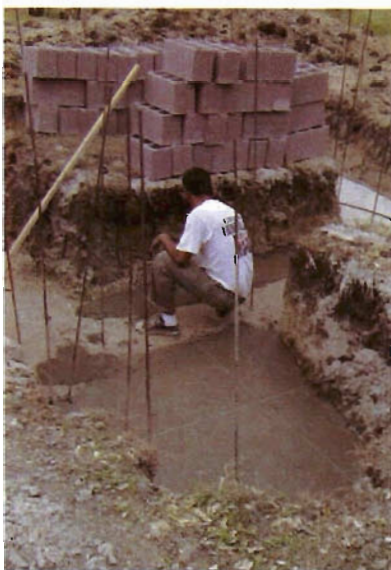
Foto 6. Colado de cimentación
