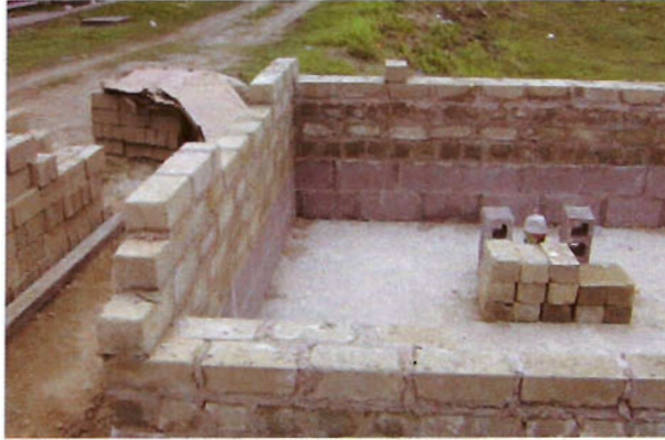
Foto 13. Muros de BTC y sobrecimiento
