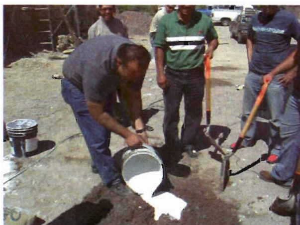
Figura 7. Mezcla de cal con arena
