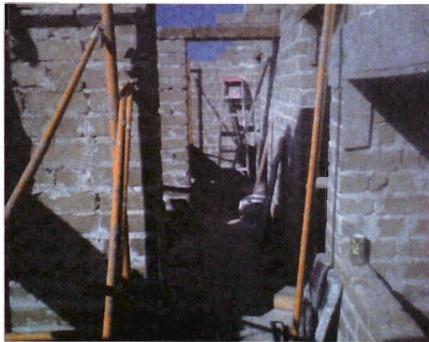
Foto 47. Proceso desplante en planta alta
