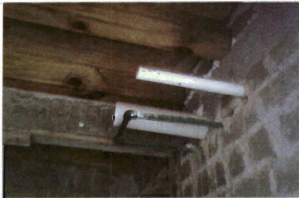
Foto 64. Detalle de alimentaciones y desagües de instalaciones hidrosanitarias
