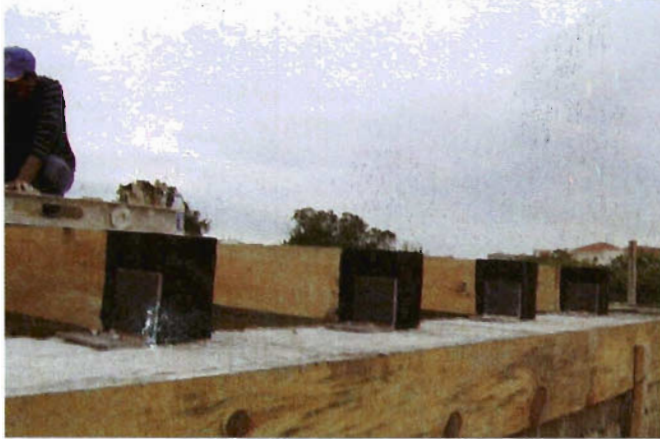
Foto 34. Detalle de anclaje
