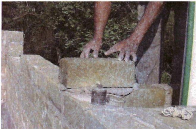
Foto 17. Detalle de cuatrapero de los BTC
