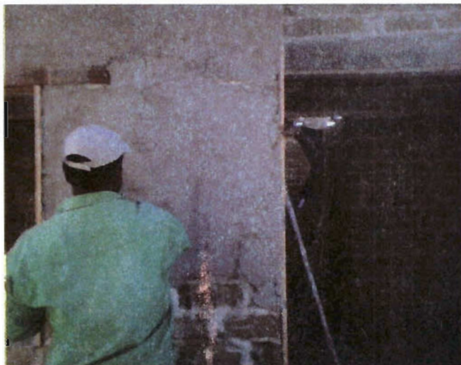
Foto 60. Aplicación del revoque de cal-arena
