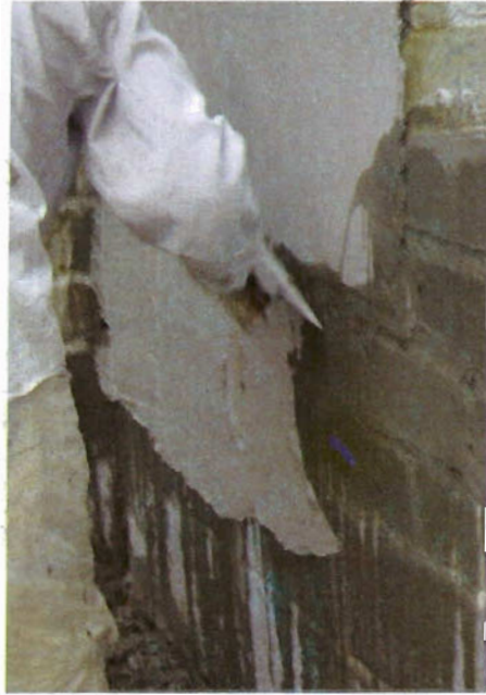
Foto 59. Aplicación de mortero cal-arena
