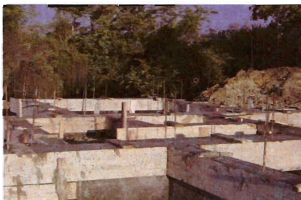
Foto 12. Vista de la cimbra y colado de cadenas de cimentación
