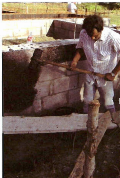
Foto 11. Proceso de impermeabilización del rodapié
