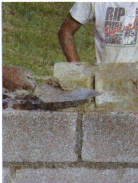
Foto 15. Detalle de desplante de muro de BTC
