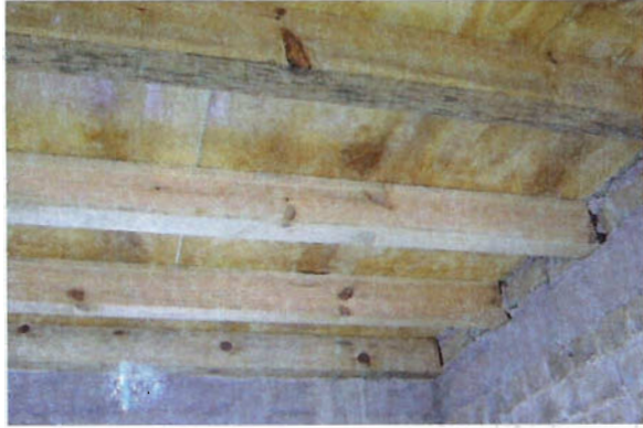
Foto 38. Vista inferior de losa de entrepiso
