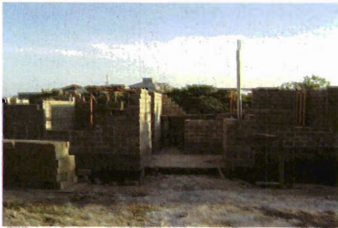
Foto 19. Proceso de desplante de muros de BTC
