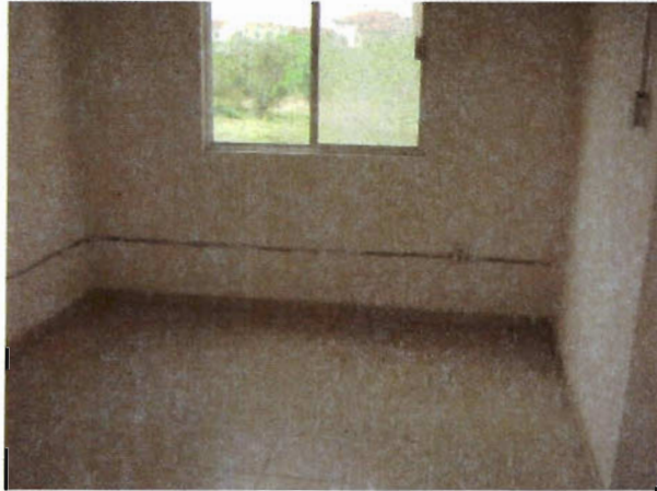
Foto 61. Detalle de piso cerámico sobre losa de entrepiso
