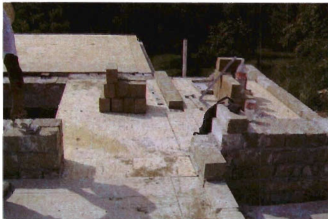
Foto 35. Colocación de cama de triplay en losa de entrepiso
