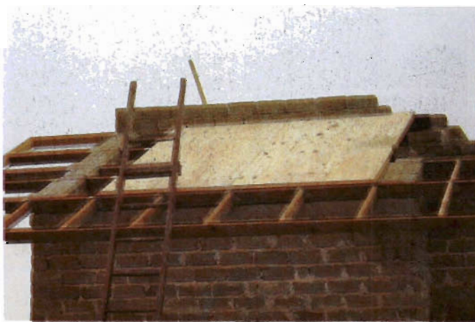
Foto 50. Aspecto de losa de azotea
