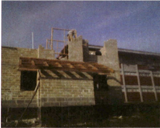
Foto 44. Estructura losa azotea cuarto de baterías
