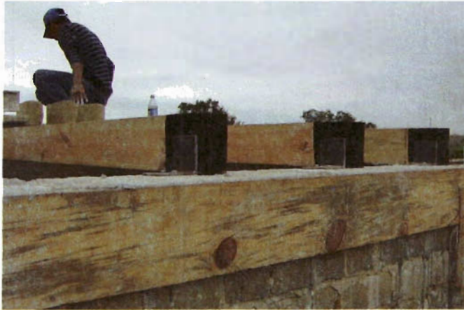
Foto 32. Detalle de anclado de las vigas de madera
