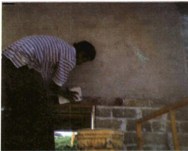
Foto 59. Aplicación de mortero cal-arena
