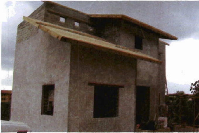
Foto 51. Losa de azotea ensamblada
