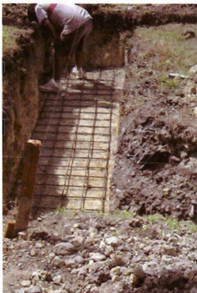
Foto 5. Introducción de acero de refuerzo en la cimentación
