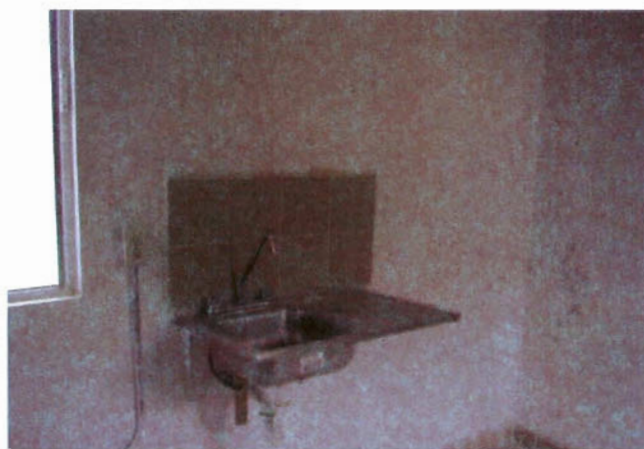
Foto 70. Fregadero en cocina
