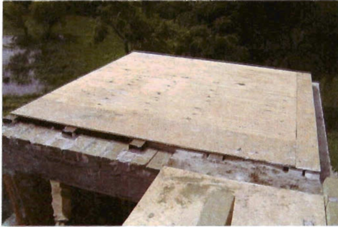
Foto 36. Detalle de losa de entresuelo
