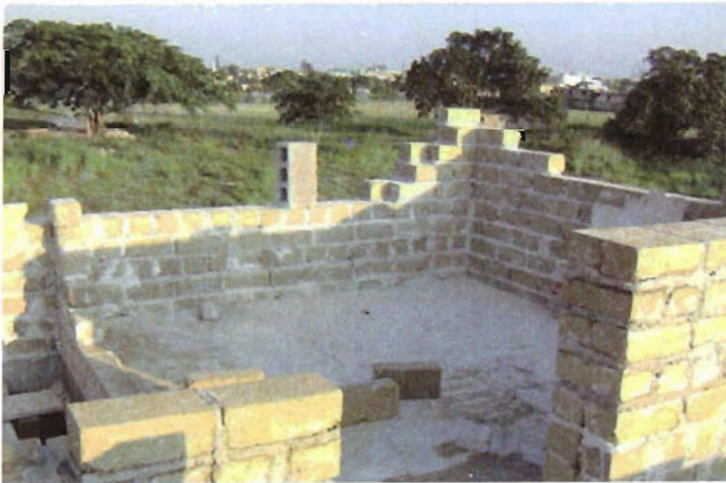
Foto 41. Desplante de muros planta alta recámara oriente
