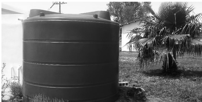
Figura 6.2. Depósito de agua
