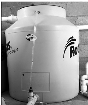
Figura 6.6. Tanque de fertilización
