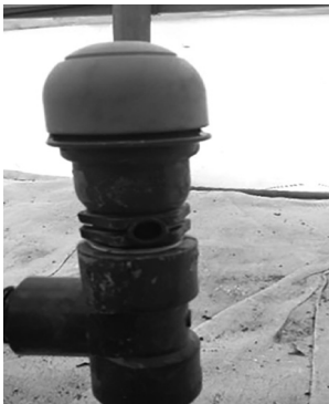
Figura 6.12. Válvula de aire
