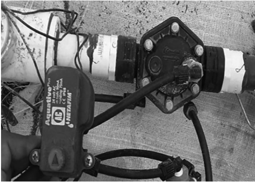
Figura 6.11. Electroválvula de pulgada y media
