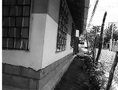
Figura 27. Acercamiento en la esquina exterior de la vivienda, nótese la membrana que impide la ascensión capilar del agua y el volado que evita también que la lluvia afecte el muro. Fuente. Kaminski y otros (2016).
