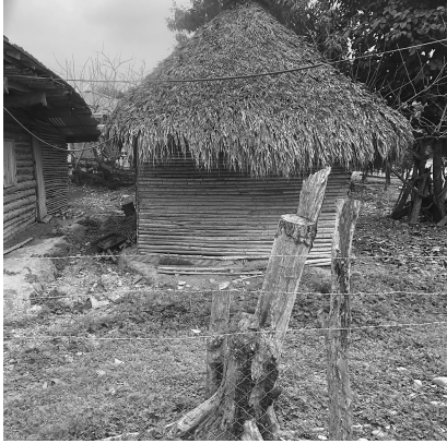
Figura 4. Vivienda de la huasteca veracruzana, construida con varas de bambú en medias cañas sin repellar y cubierta con estructura de madera y bambú con envoltivo de palma y zacate. Fuente: Fotografía del autor.
