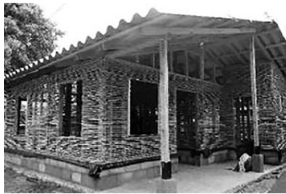
Figura 24. Vivienda construida con bambú y madera en El Salvador, antes de la aplicación del aplanado (render). Las viviendas de bambú requieren grandes volados en todas sus fachadas y puede observarse el desplante de 2 hiladas de block rematadas por una membrana impermeable, que puede ser polietileno. Fuente. Kaminski y otros (2016).
