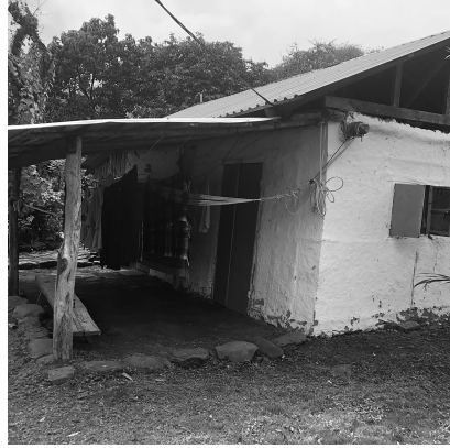
Figura 5. Vivienda de la huasteca veracruzana, construida con bahareque con tierra y zacate mezclados para repello de muros, cubierta con armadura de madera y lámina galvanizada. Esta vivienda recién la han restaurado los habitantes de esta. Fuente: Fotografía del autor.
