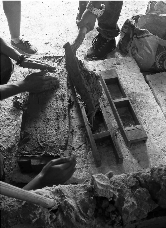
Figura 1. Construyendo con bloques de tierra o adobes, en práctica de clase, realizada en FADU-UAT. Fotografía. J. A. Espuna
