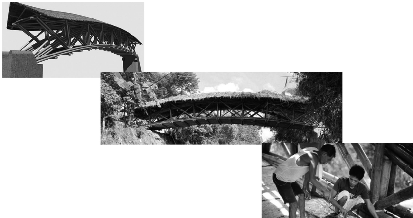
Figura 21. Puente en Davao Filipinas construido durante abril-mayo del 2011 y actualmente en uso, diseñado por Andrea Fitrianto de Consultores: Jeffry Camarista & Evtri Tabanguil (fundación), Natalia Dulcey, bamboo networks. Fuente: Tomado de Archdaily.mx, Recuperado en mayo de 2019.
