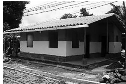
Figura 25. Vivienda terminada en El Salvador. Fuente. Kaminski y otros (2016).
