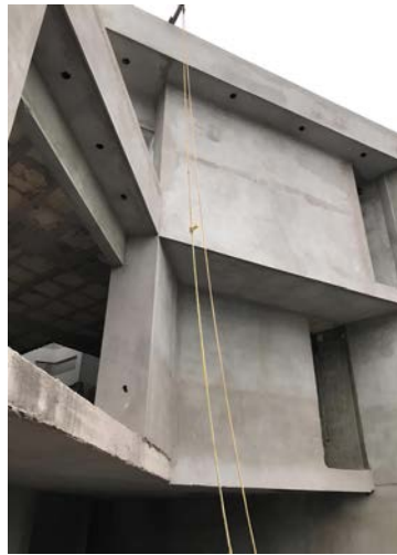
Figura 59. Detalle de la fachada principal. Casa Z. A.
