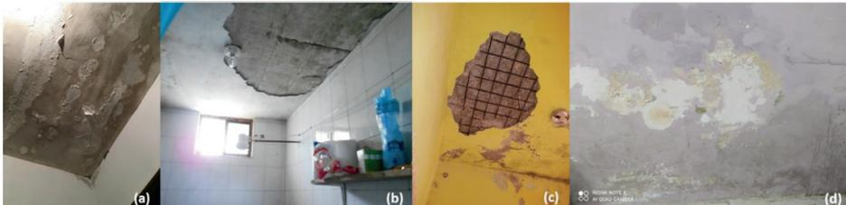
Figura 12. Lesiones observadas en losas. (a) eflorescencias, (b) pérdida de aplanado, (c) acero expuesto y (d) eflorescencias con estalactitas
