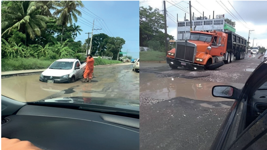
Figura 13. Carretera libramiento al Puerto Dos Bocas (principal acceso a la terminal marítima TMDB y API en pésimas condiciones)
