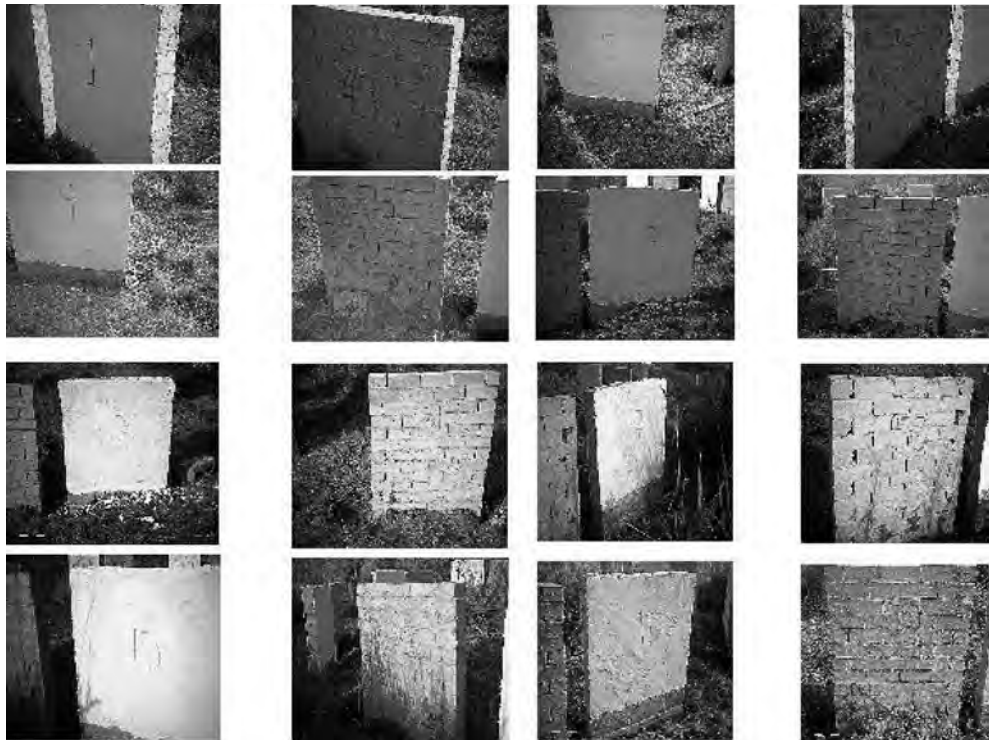
Figura 1. Fotografías de los muros del octágono núm. 1, en el orden en que se indican en el cuadro superior
