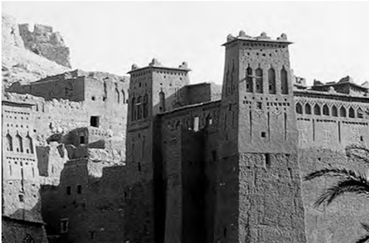
Figura 2. Construcción de tierra en Marruecos
