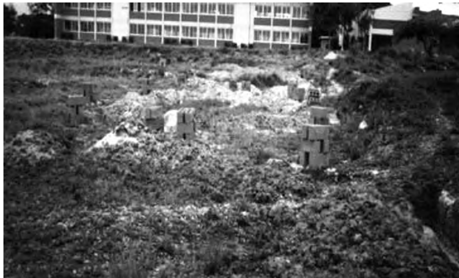
Figura 10. Construcción de zócalos
