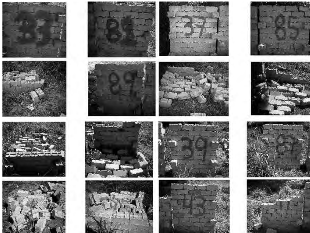
Figura 19. Fotografías de los muros del octágono núm. 5, en el orden en que se indican en el cuadro superior
