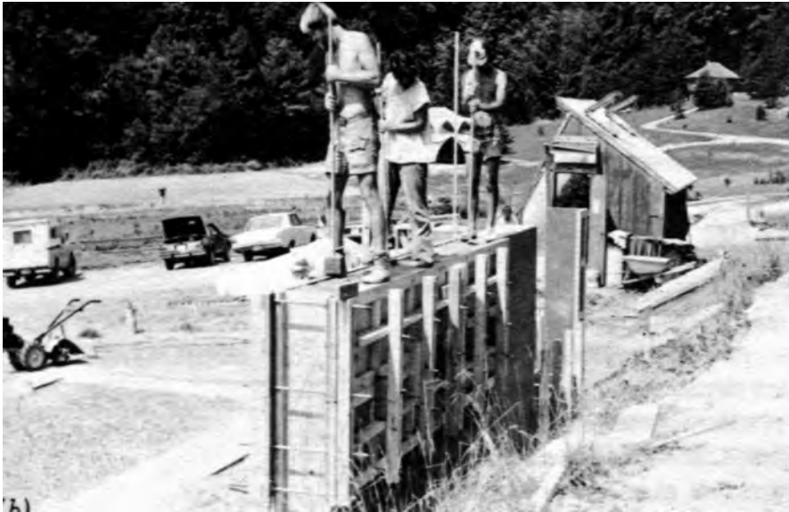
Figura 6. Encofrados para tapial
