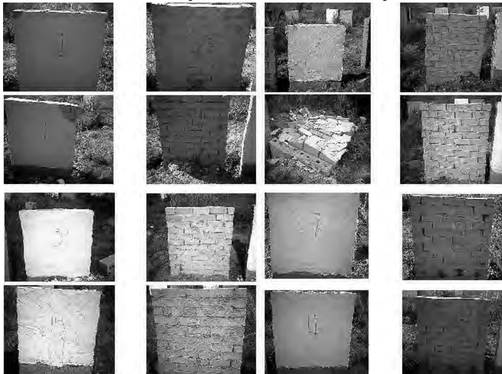
Figura 15. Fotografías de los muros del octágono núm. 1, en el orden en que se indican en el cuadro superior
