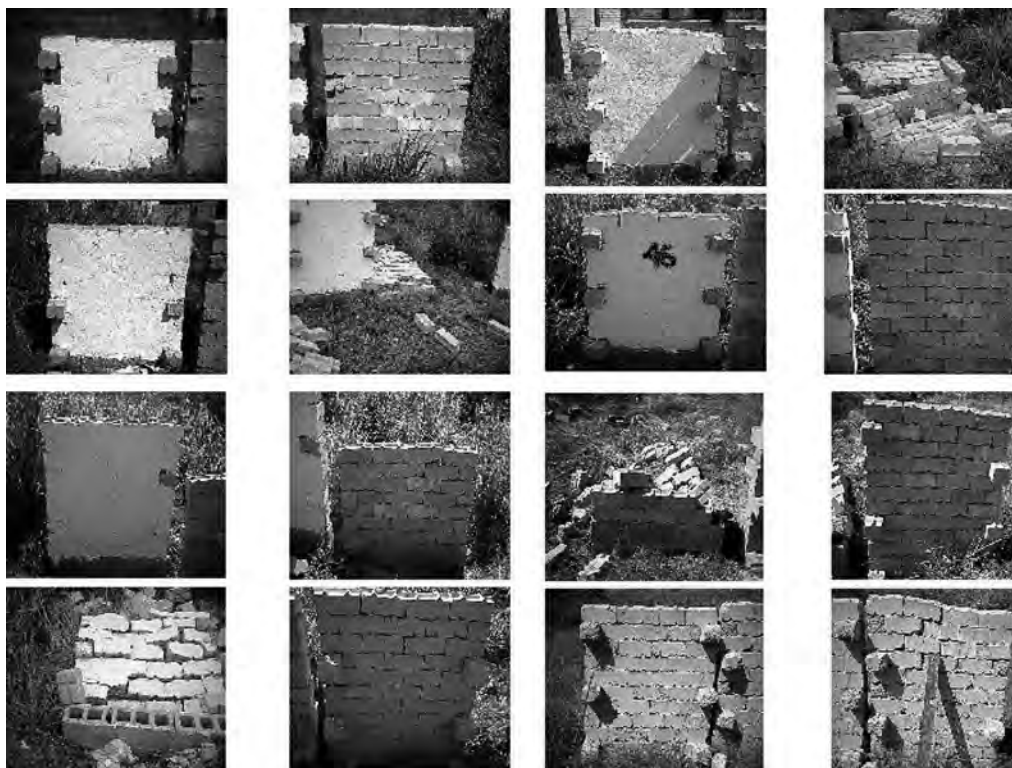
Figura 20. Fotografías de los muros del octágono núm. 6, en el orden en que se indican en el cuadro superior
