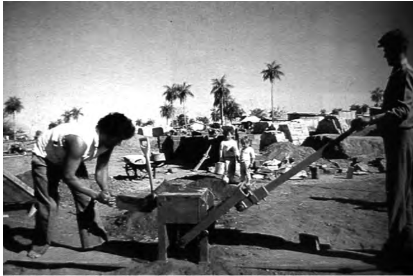
Figura 10. Fabricación de Bloques de Tierra Comprimida
