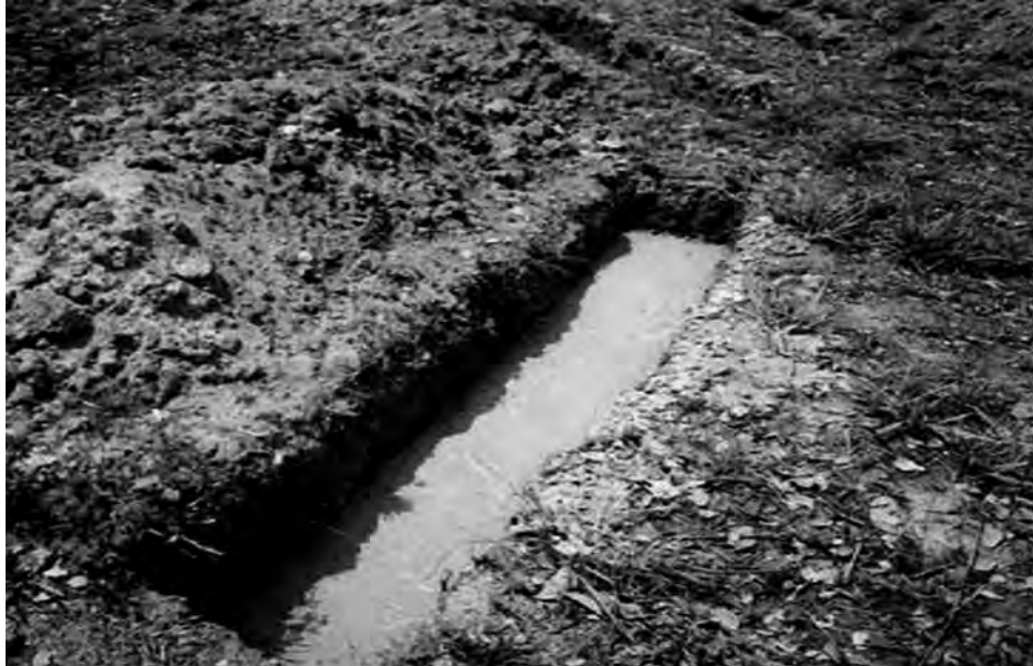
Figura 9. Vaciado o colado de concreto de cimentación
