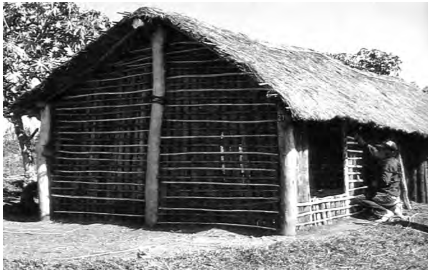
Figura 7. Construcción de bajareque
