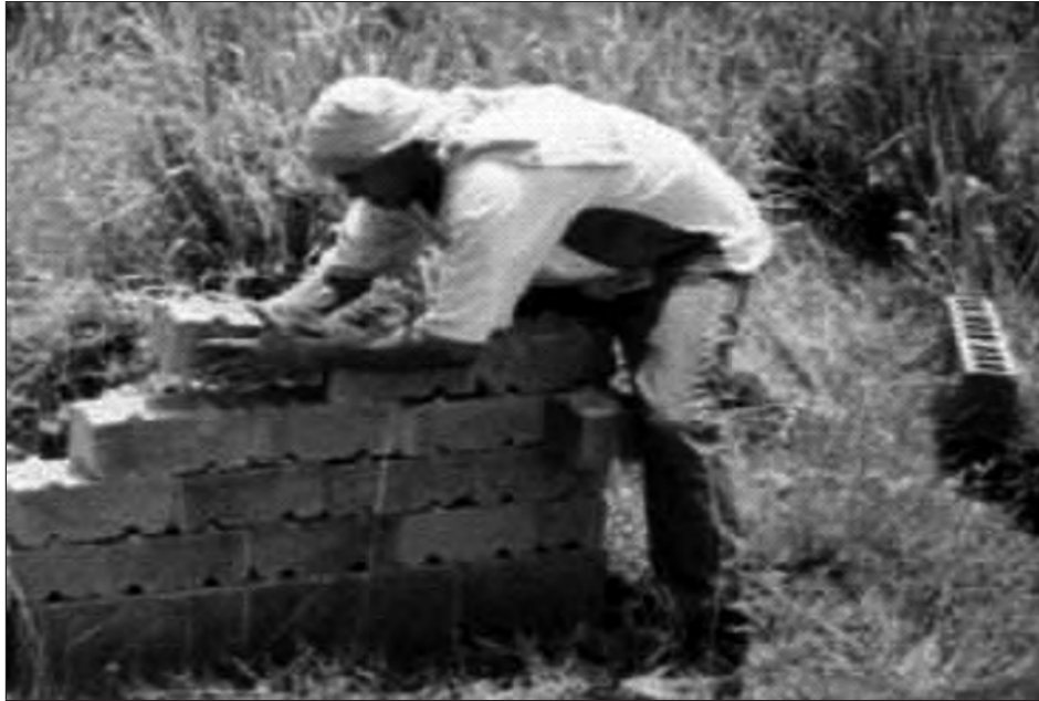
Figura 11. Construcción de los muros del Módulo núm. 6
