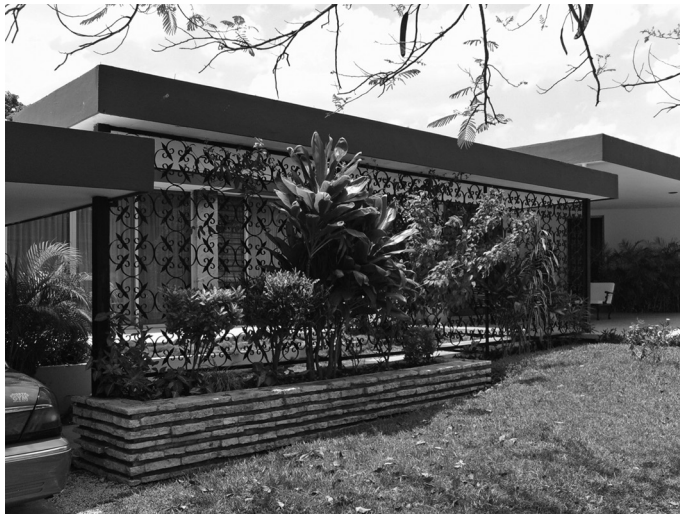
Fig 10. Modernidad Organicista: Casa Palomeque en Colonia México Fuente: Fotografía del autor.
