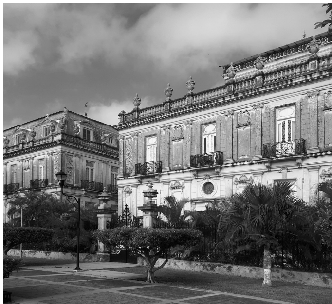
Fig 4. Modernidad Porfiriana, Esquema Cerrado: Casas Cámara en Paseo de Montejo Fuente: Fotografía del autor.
