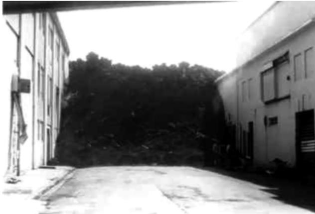
Fig. 3.1. Vista hacia el sur-sureste del frente de un derrame de lava solidificado en una calle que separaba las plantas procesadoras de pescado *Fiskidán hf.* (Izquierda) y *Ísfélag Vestmannaeyja hf.* (derecha). A este frente se le dirigieron chorros de agua para tratar de enfriarlo y así detener su avance. Fotografía tomada el 23 de julio de 1973 por Richard S. Williams, Jr. Fotografía de dominio público del Servicio Geológico de Estados Unidos.
